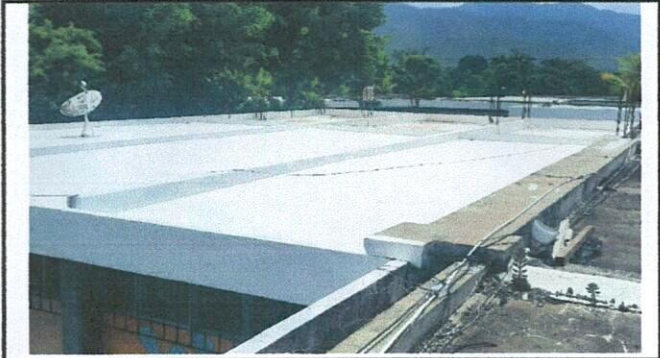
Foto 2: IMPERMEABILIZACION DE LOZA
