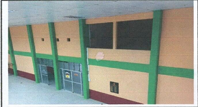
Foto 4: PINTURA EN MUROS INTERIOR
